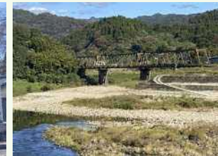
旧第一江川鉄橋
