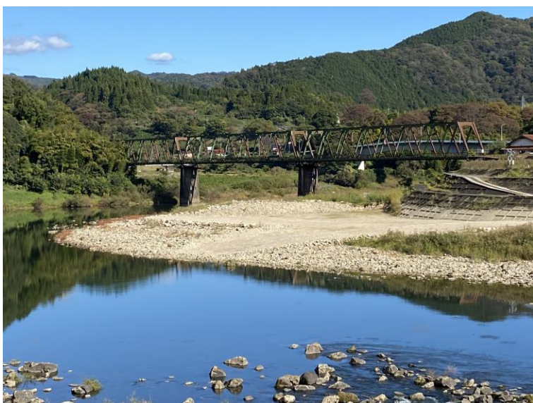
江の川に架かる旧三江線の鉄橋（旧第一江の川鉄橋）
