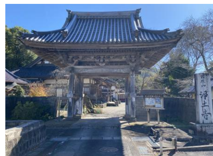
浄土寺四脚門
