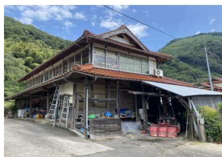
養蚕を行っていた桁行方向が長い納屋
