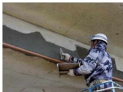
写真3 断面修復状況
