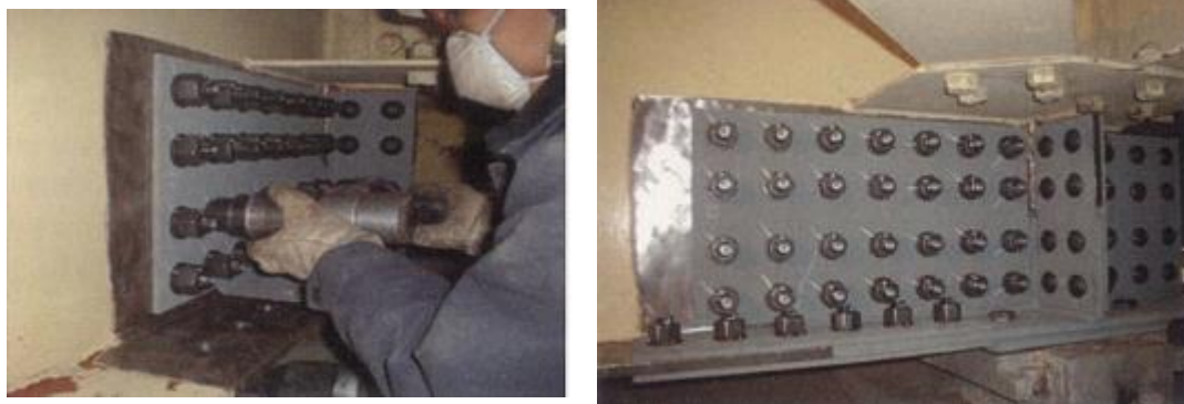
写真1 当て板工実施状況
