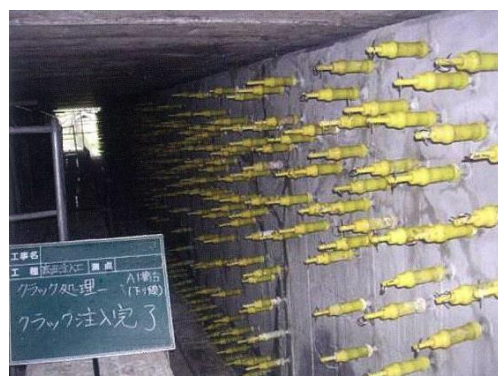
写真2 ひび割れ注入状況
