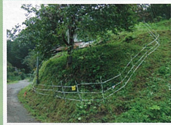
電気柵の設置
