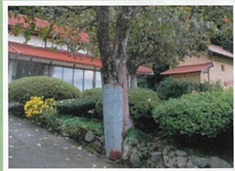
トタン板巻き付け
