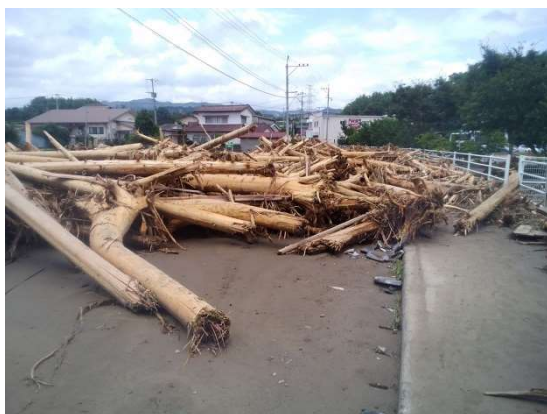
写真 2-3 道路や民地に流入した流木 (平成 29 年 7 月豪雨 福岡県朝倉市)
