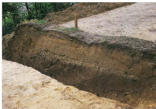
版築状突き固め層
