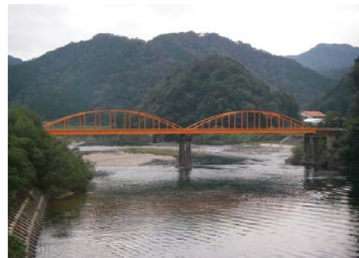
No.12 都賀行大橋
