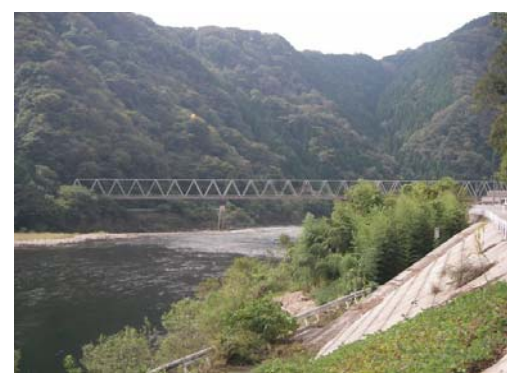
No.4 第四江川橋梁
