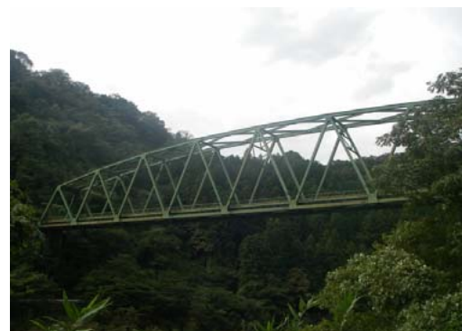
No.7 第二江川橋梁
